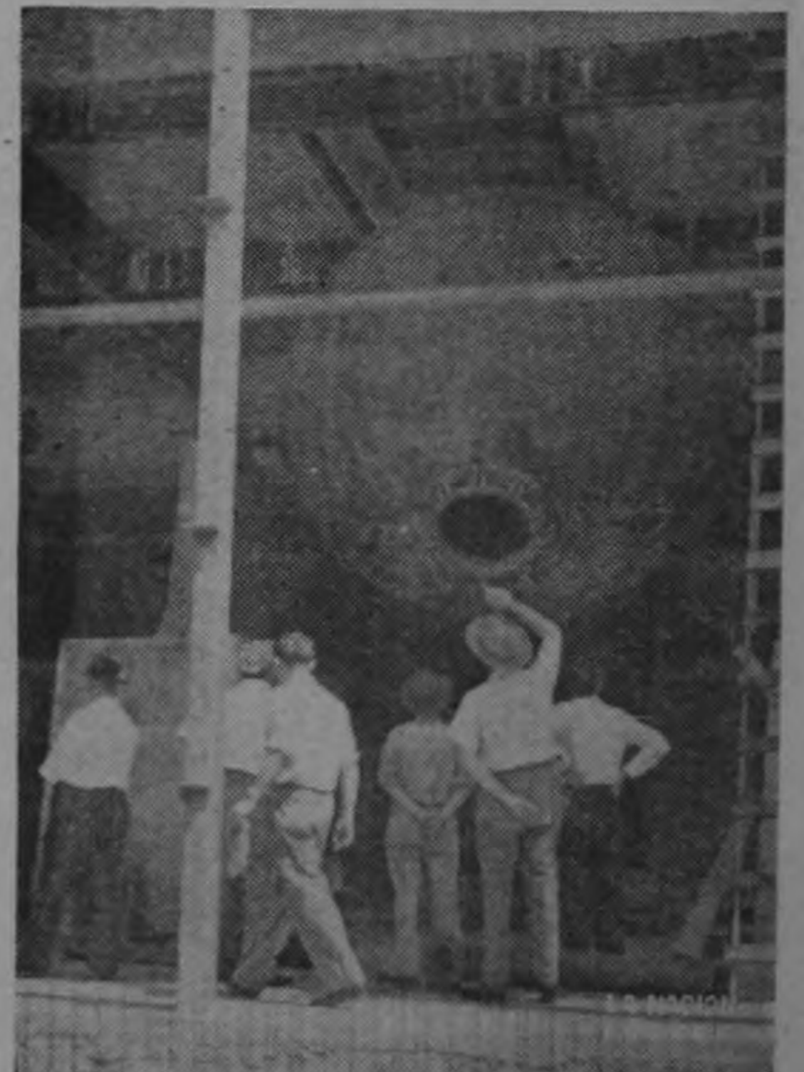
Detalle de uno de los grandes digestores esféricos rotativos enseñando su boca de cargar
